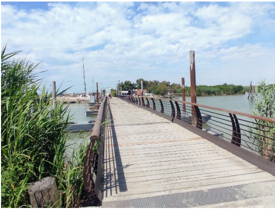
Barricata: Ponte pedonale verso la spiaggia
