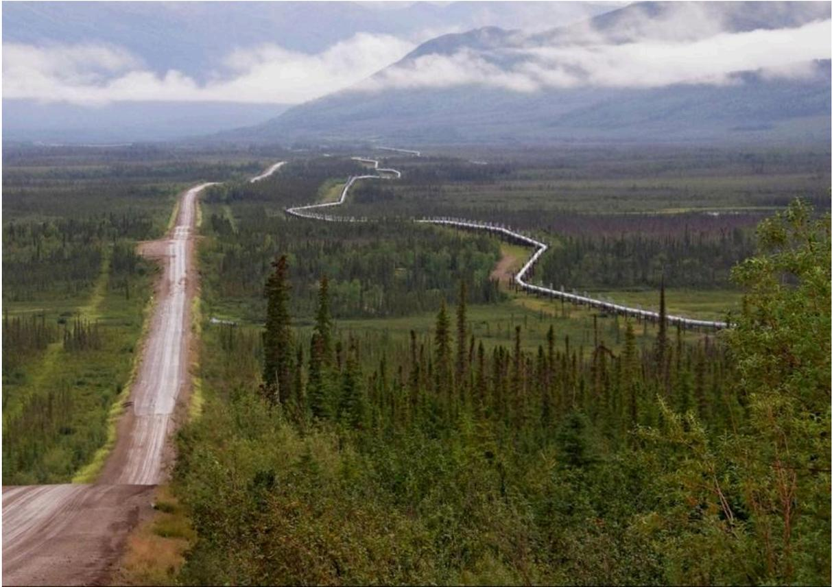
Il tubo è appoggiato sui pali e libero di muoversi per poter oscillare in caso di terremoto. Si notano dei radiatori in alluminio alla sommità dei pali: si tratta di heat pipes (tubi di calore), che servono a raffreddare le fondazioni per evitare lo scongelamento del terreno. Funzionano in modo analogo ai frigoriferi trivalenti del camper. Ce ne sono circa 124000.
