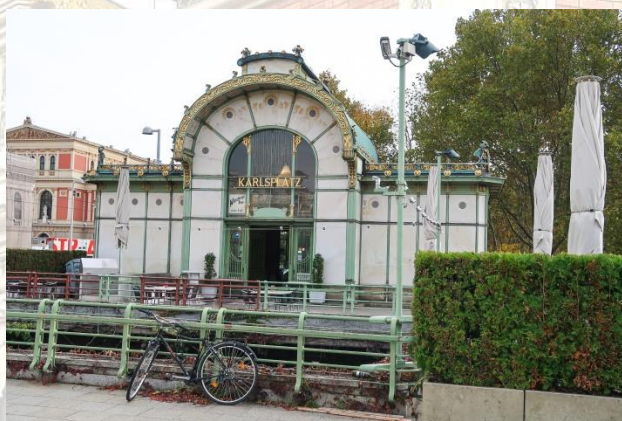
Foto 1 metro di Karlsplatz Vienna
