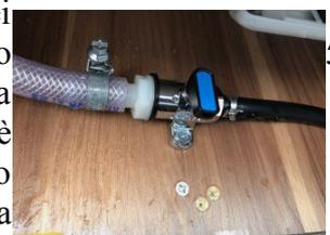
al condizionatore, si era rotto il rubinetto di arresto dell'acqua che non permetteva il flusso).
