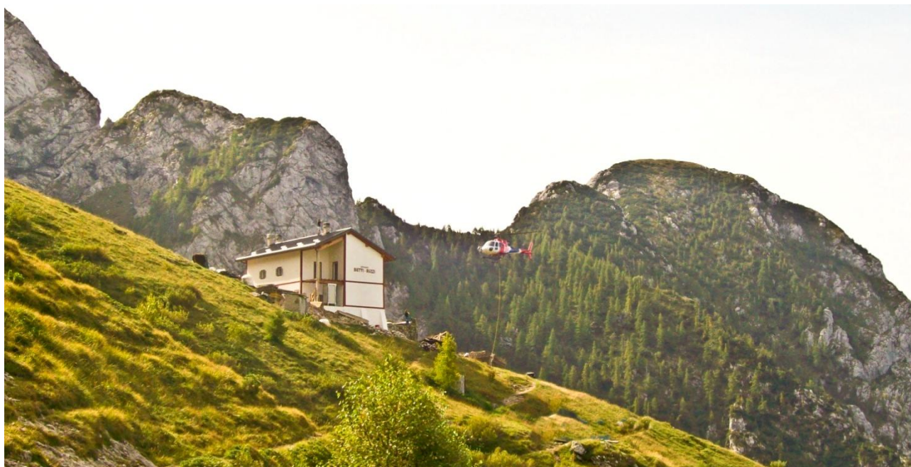
7 - La capanna Bietti Buzzi a fine ristrutturazione.
