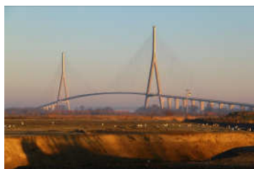
Pont de Normandie
