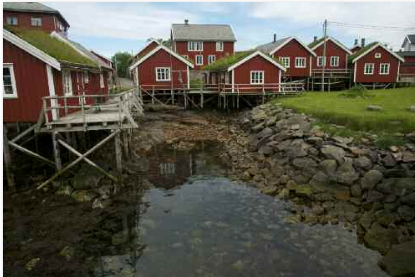
REINE - Casette con il tetto di torba
