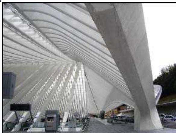
La costruzione ci appare caratterizzata da una immensa e spettacolare volta centrale d'acciaio e vetro sostenuta da strutture in cemento armato bianco: una cattedrale di luce del terzo millennio. Infatti la luce naturale, filtrando dalla volta, inonda tutta la struttura e, attraversando i mattoni in vetrocemento delle banchine dei binari, arriva fino ai piani inferiori della stazione, dove ci sono i parcheggi, le sale d'attesa e i negozi.
